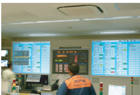
守口門真消防局司令室
